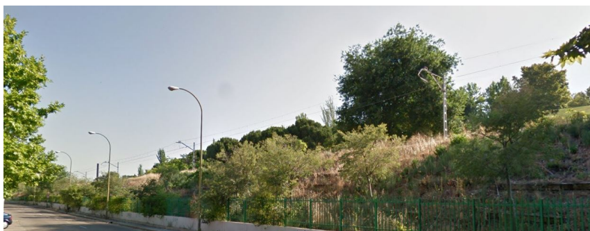
Vías ferroviarias: Talud junto a las vías del tren en la calle Puerto de la Cruz Verde (Arganzuela)
